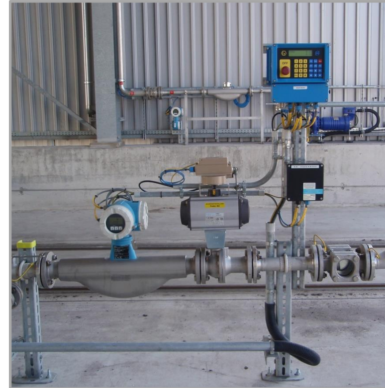
LKW-Verladung mit dem E+H Promass 84F und einem Kugelhahn mit pneumatischen Antrieb und 4-20 mA Stellungsregler
